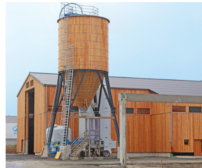
Straßenmeisterei Goslar | Streustoffflager mit Silo
